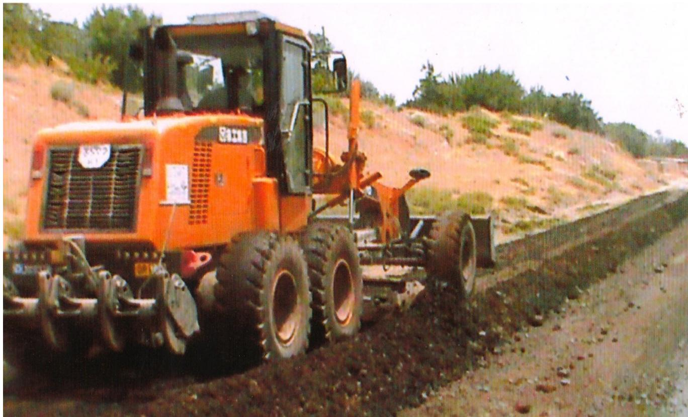
Жумладан, вилоятдаги 4Р-105 "Дарбанд қ. - Бойсун ш. - Элбаён қ." автомобиль йўлининг техник ҳолатини яхшилаш ҳамда йўл қопламасини тиклаш бўйича бир қатор ишлар амалга оширилди. Йўлнинг 65-70 километрлари оралиғида қум ва шағал аралашмасидан асос ёқизилди.
