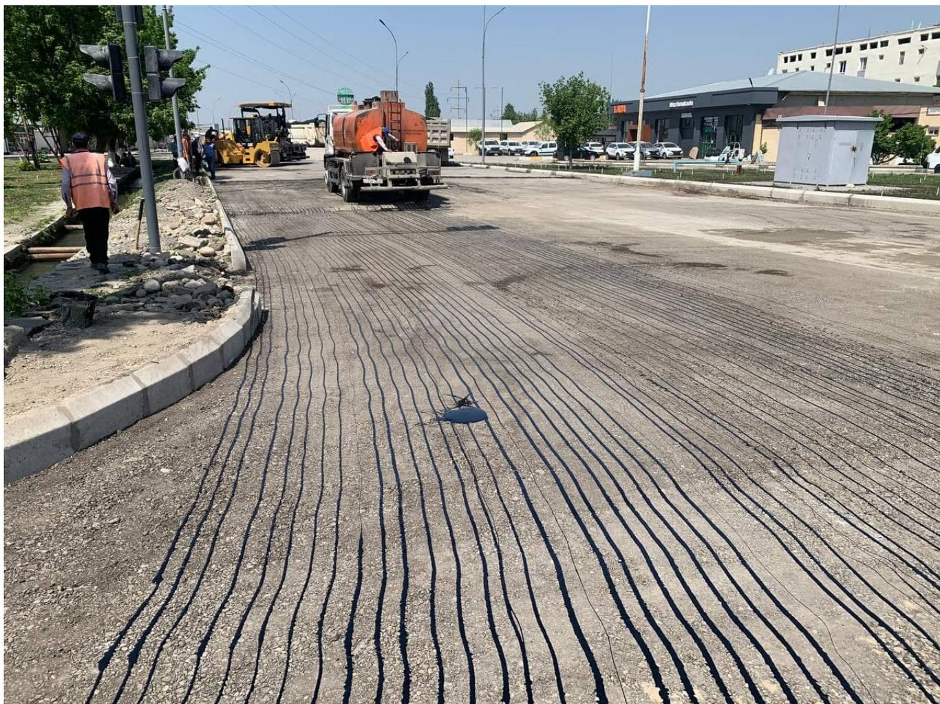
Ayni paytda mazkur ob'ektda asfaltobeton qoplamasini yotqizish ishlari qizg'in davom ettirilmoqda.
