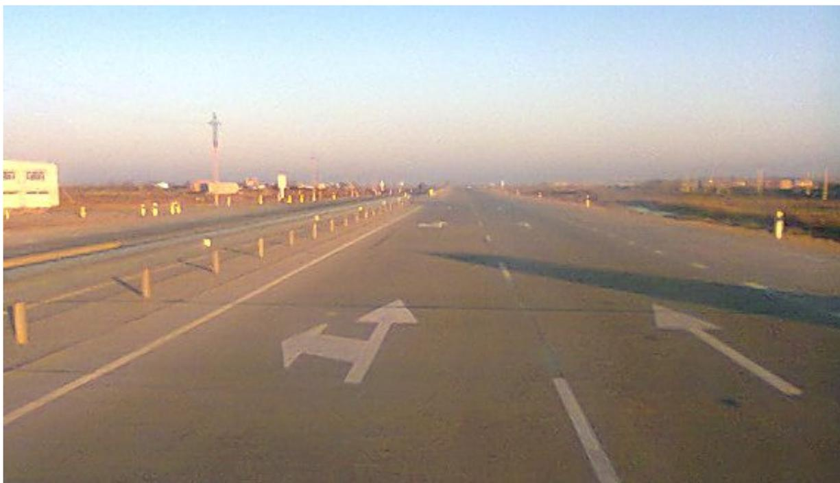
После проведенных работ состояние дорог на вышеназванных объектах со II-технической группы была переведена на I-группу, а способность грузоподъема была приведена к степени предназначения 13 т. на одну ось.
