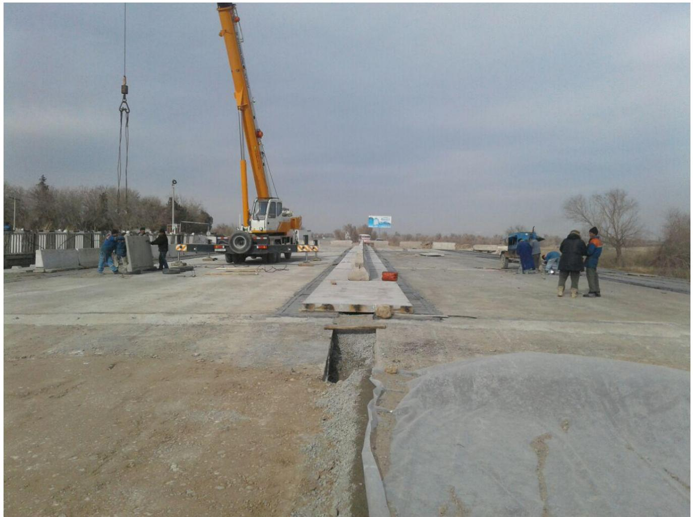
Проектировщики и строители придают огромное значение современному виду и всесторонней прочности моста и устанавливают 72 штуки бетонных свай на опорные берега, 104 штук металлических труб длиной 14 метров каждая на среднюю опорную часть.
