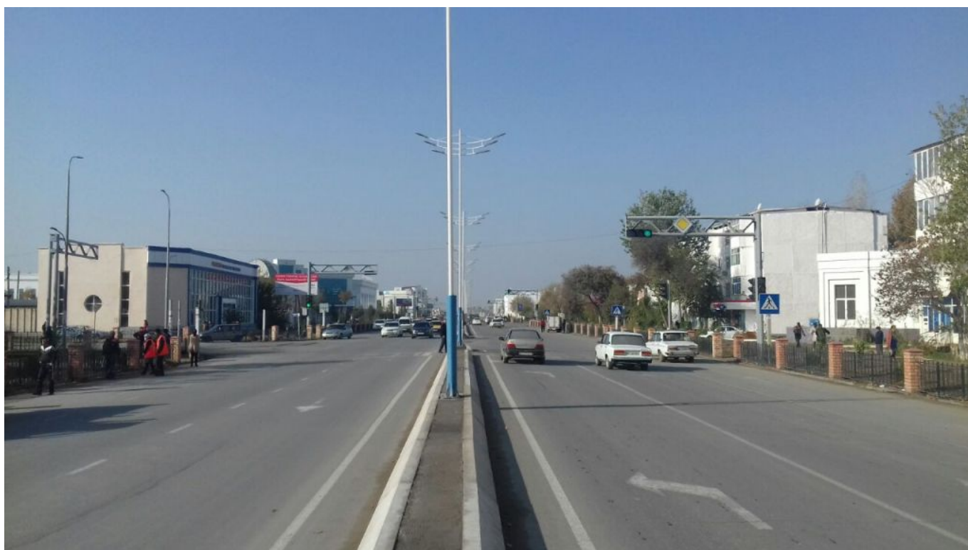
Реконструированная дорога в Сирдарьинской области
