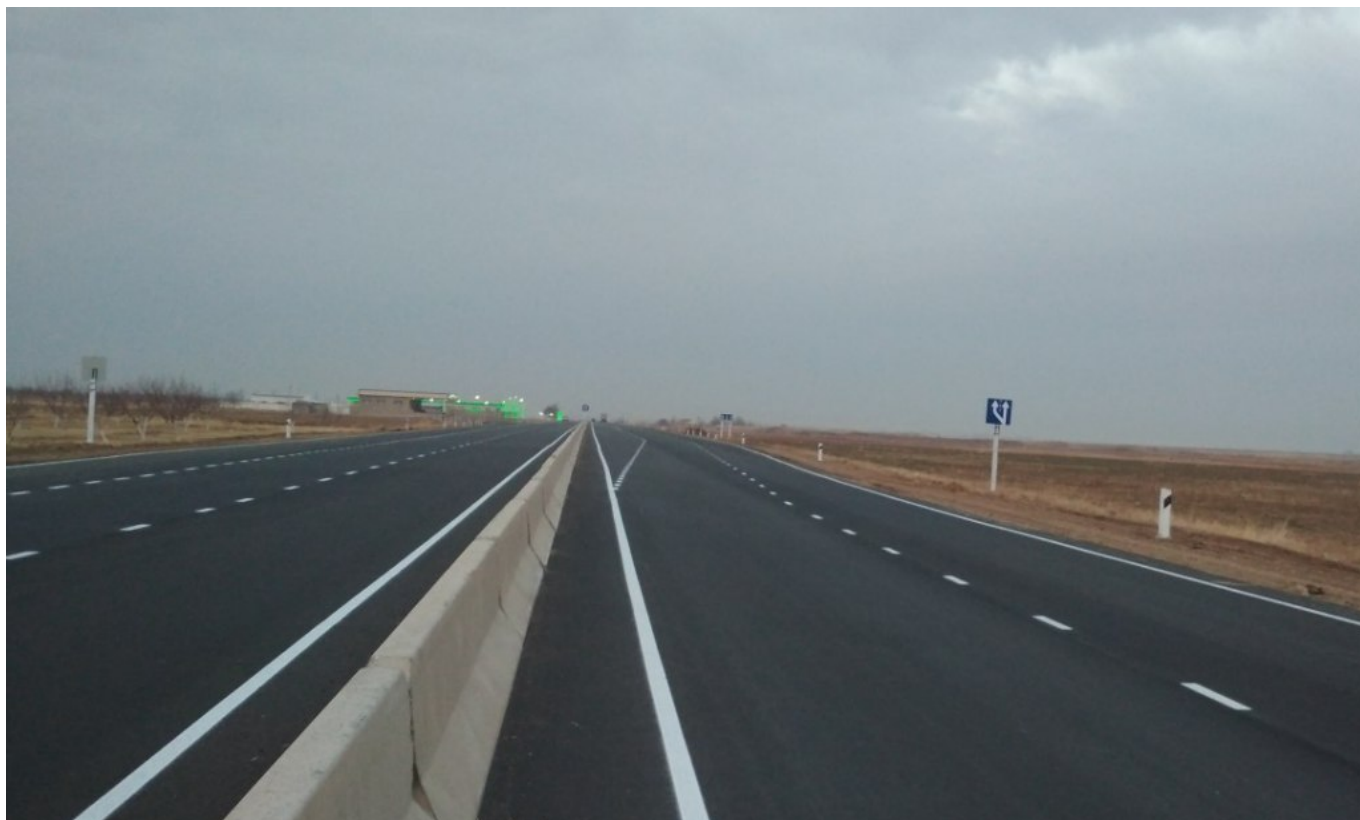
После ремонта (Кашкадарья)
