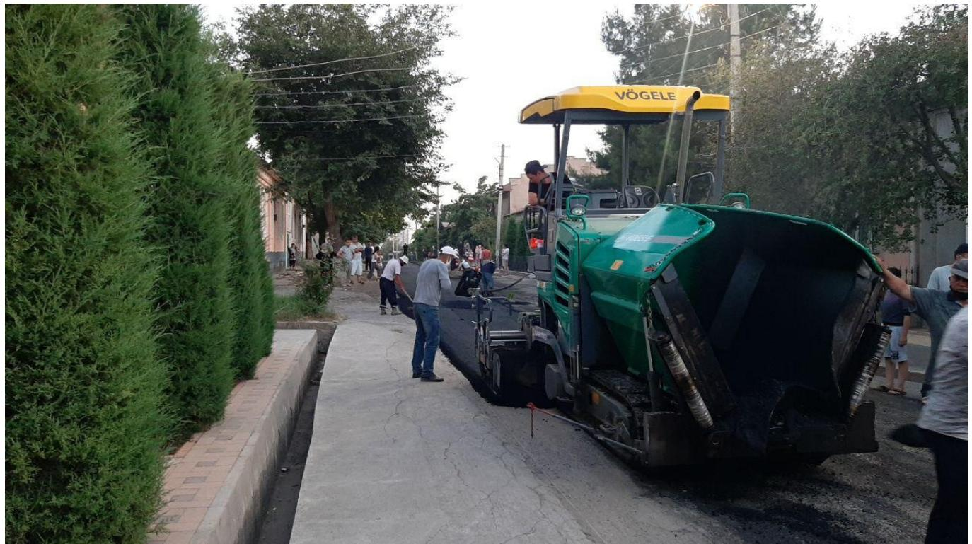
Ta'kidlab o'tmoqchimizki, mazkur ob'ektlardagi – yo'l asosini qurish, asfalt-beton va tsement-beton qoplamlarni yotqizish, temir-beton lotoklarni montaj qilish, piyodalar yo'laklari, velosipedlar uchun maydonchalar barpo qilish hamda yoritish va sug'orish tizimlarini montaj qilish kabi ishlarning aksariyati yakuniga yetdi.
