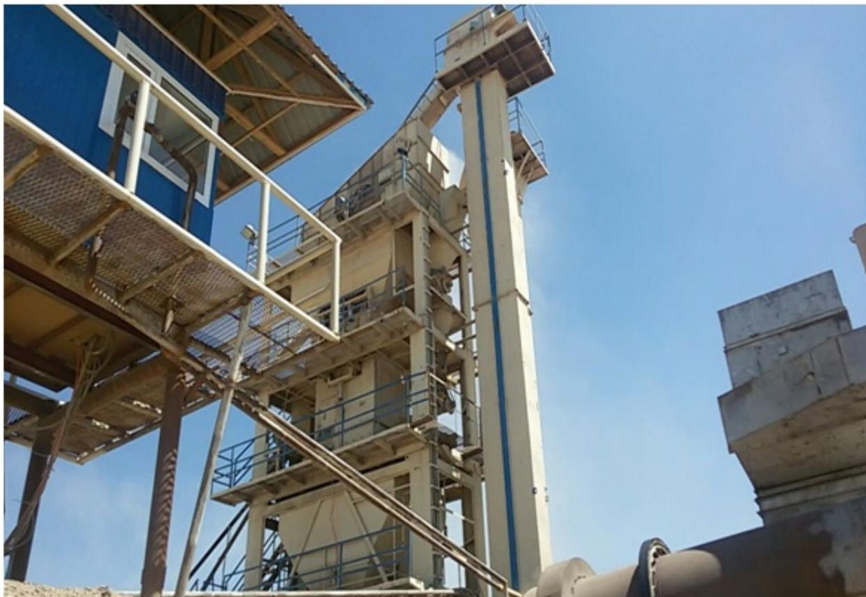
Xususan, Eron davlatida ishlab chiqarilgan, "AMS-120" markali, soatiga 120 tonna asfalt-beton qorishmasi tayyorlash quvvatiga ega bo'lgan asfalt-beton zavodining ishga tushirilishi yo'lchilar uchun katta yutuq bo'ldi. Mazkur zavodda joriy yilda 2016 yil investitsiya dasturi asosida qayta qurilgan - "Samargand-Buxoro-Turkmanboshi" avtomobil yo'lining 116-126 kilometrlari qismi ob'ektiga uzlucksiz sifatli mahsulot yetkazib berildi.
